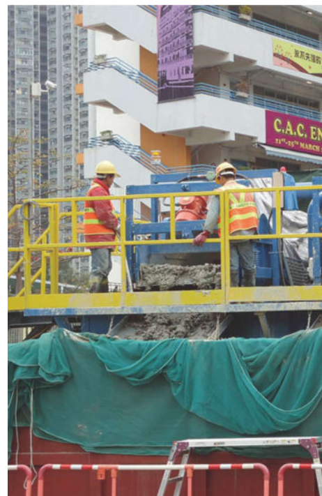
盾构施工泥浆净化
